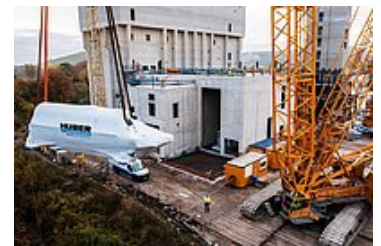
Gli essiccatori sono sollevati direttamente nell'edificio sul livello preparato
