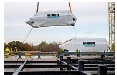
Dopo che gli essiccatori sono stati sollevati in posizione, la costruzione in acciaio di cui sopra può ora continuare
