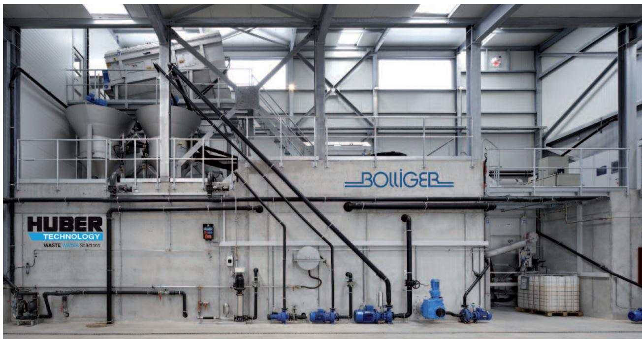
*Geschickte Anordnung der Pumpentechnik für leichte Zugänglichkeit bei Wartungsarbeiten*
