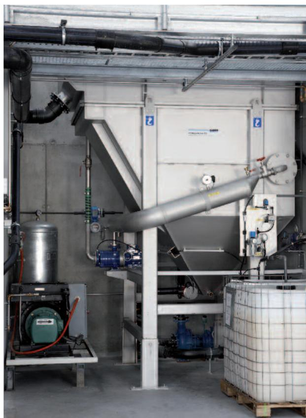
Prozesswasseraufbereitung mit HUBER Druckentspannungsflotation HDF
