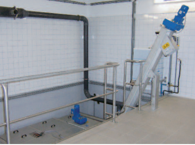
ROTAMAT® Komple Tesis Ro5 çıkışında entegre kum yıkama
