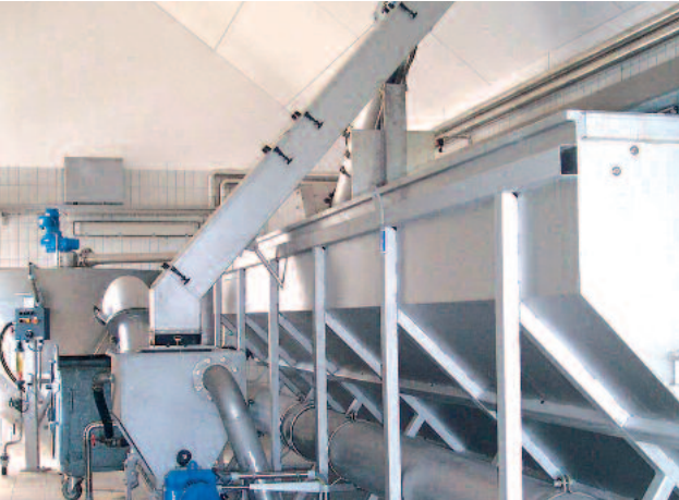
ROTAMAT® Komple Tesis Ro5 çıkışında ileri yıkama işlemi için WAP/SL Yıkama Presi
