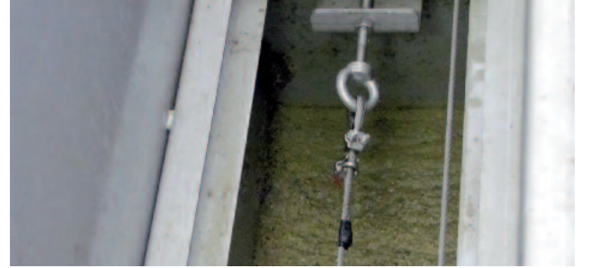
Yağ tutucudan gresin kürek ile alınması. Uzun kum tutucu küreğinin işlevsel prensibine göre gres küreği yüzen yağı ve gresi pompa yağ haznesinin içine iter.
