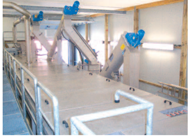
Kokusuz tutulan malzeme deşarjı ROTAMAT® Komple Tesis Ro5
