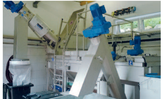
Entegre Kum Yıkama Ünitesi ile Komple Tesis
