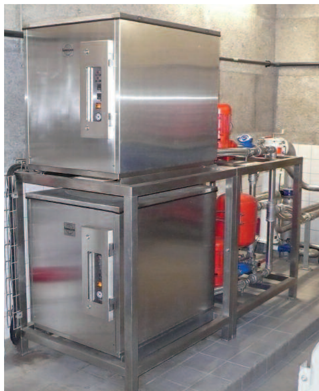
Pompe à chaleur spécifique avec échangeur eau-eau intégré.
