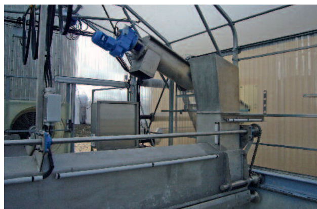
La vis de répartition permet de déposer automatiquement la boue deshydratée sur toute la largeur de la surface de séchage.
