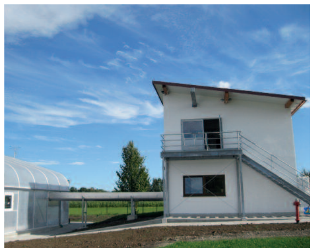
Convoyage par vis des boues déshydratées vers le sécheur et répartition automatique sur la surface de séchage.
