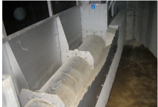
Tamiz de aliviadero ROTAMAT® RoK 2 con un dispositivo para controlar el caudal de alivio.
