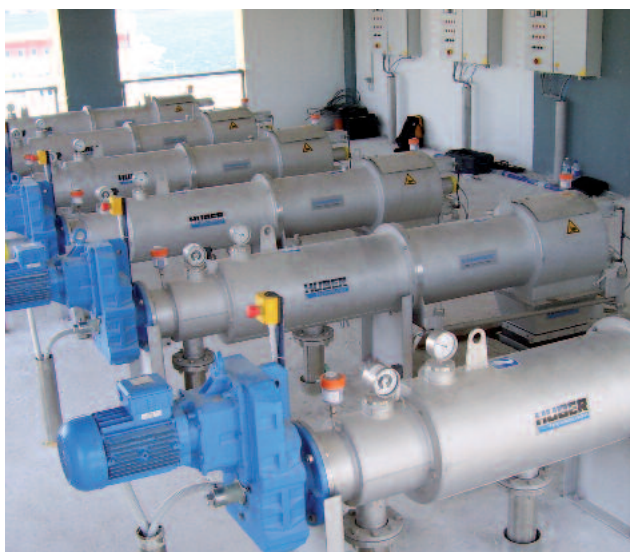
希腊雅典污水处理厂的污泥过滤
