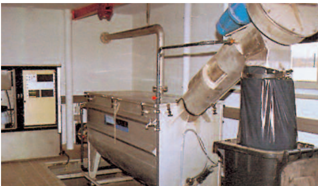
Estação Receptora de Efluentes ROTAMAT® Ro 3 com leitor de cartão para a identificação de clientes, fluxômetro e amostrador automático
