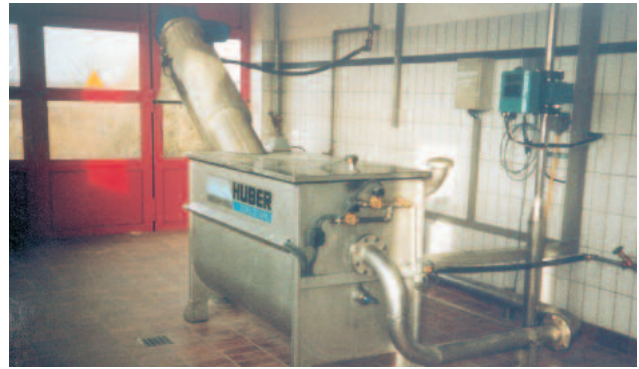
Instalação interna da Estação Receptora de Efluentes ROTAMAT® Ro 3
