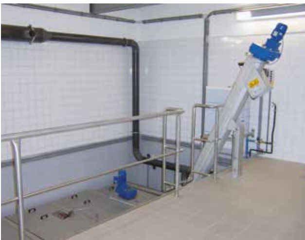
Integrierte Sandwäsche am Ende der HUBER Kompaktanlage ROTAMAT® Ro5.
