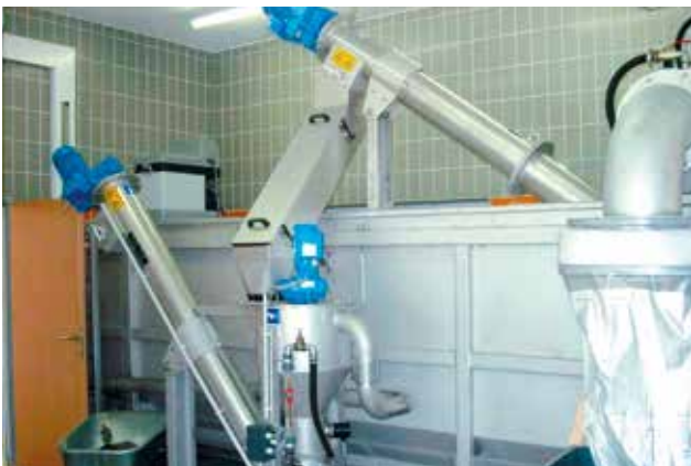
Klassierschnecke mit nachgeschalteter HUBER Sandwaschanlage RoSF4 TC.
