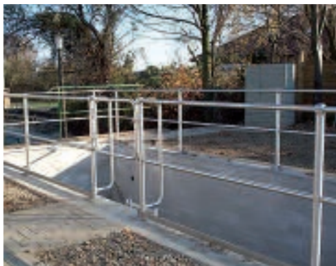
Perfektní nerezové zábradlí
