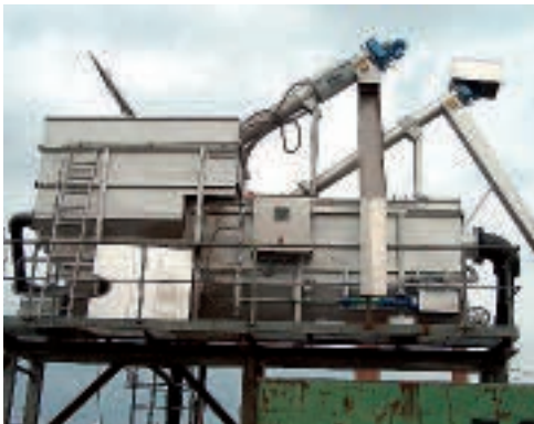
HUBER ROTAMAT® kompaktní zařízení Ro5K s integrovaným předčištěním 1 mm
