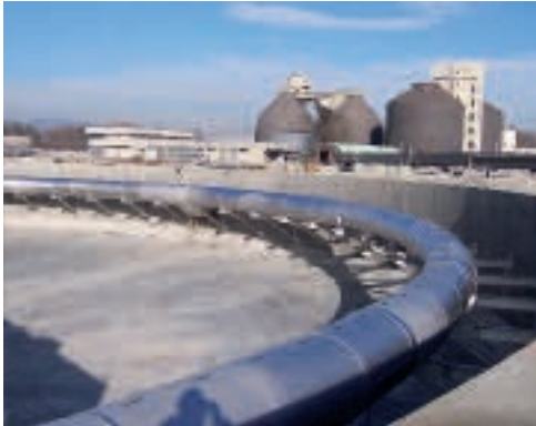
HUBER ponorná trubka pod hladinou vody zajišťuje optimální odtah
