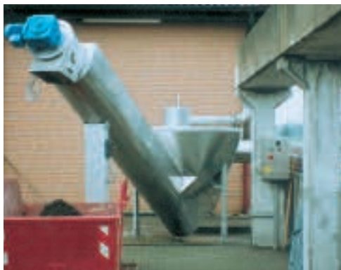
COANDA separátor písku za pískovým žlabem
