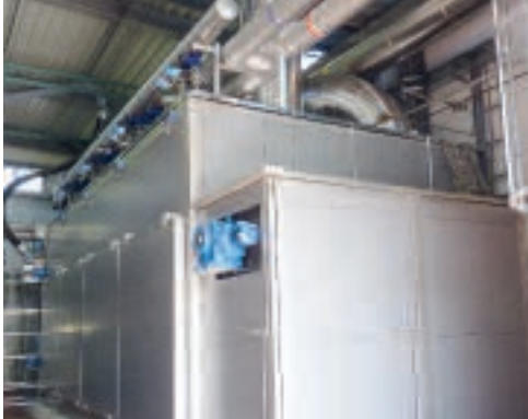
HUBER pásová sušička BT pro sušení kalů až do > 90 % obsahu sušiny.
