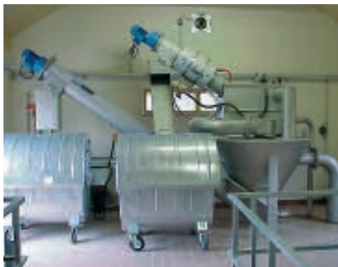
Kompaktní mechanické předčištění pro malé čistírny
