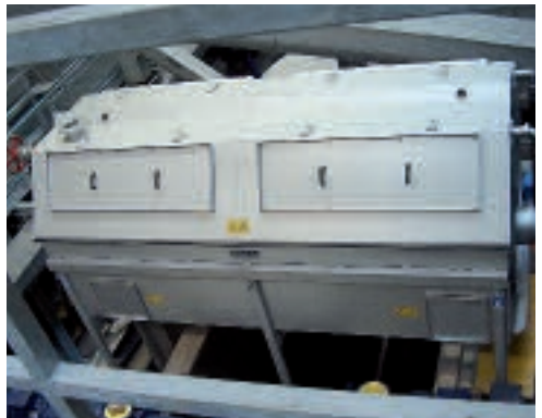
ROTAMAT® RoMesh® pro jemnost čištění 0,2 až 1,0 mm
