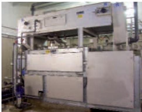
HUBER Bogenpresse – možno kombinovat se zahušťovačem Drainbelt pro zvýšení kapacity
