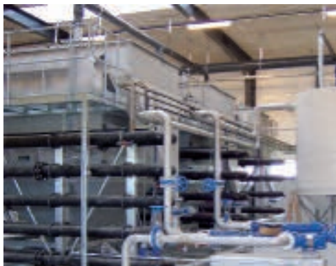
HUBER HDF - flotační stanice s chemickým stupněm
