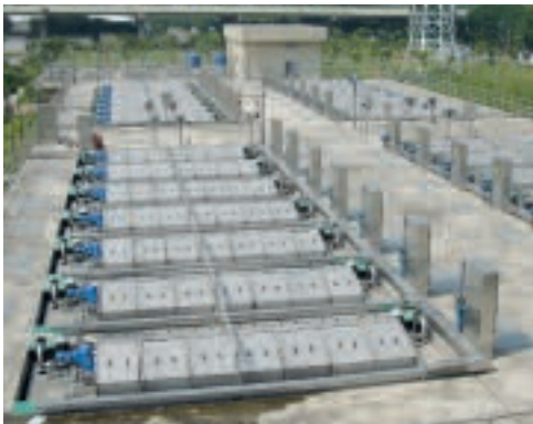
Mikrosíto RoDisc® může mít až 20 disků v jednom zařízení
