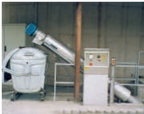
ROTAMAT® šnek se sítem Ro 9 - ekonomické řešení pro malá množství odpadní vody
