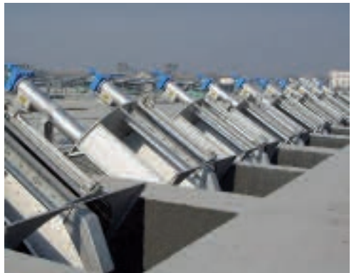
ROTAMAT® rotační česle Ro 1k instalaci do žlabu event. do nádoby
