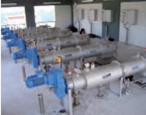
STRAINPRESS® – Kontinuální separace hrubých částic pod tlakem
